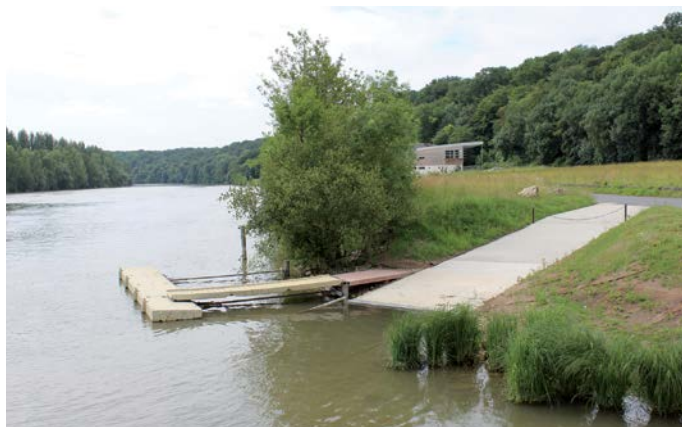
Port de plaisance de Valvins, aménagements récents des pontons, grue et mise à l'eau pour pratique de la voile
