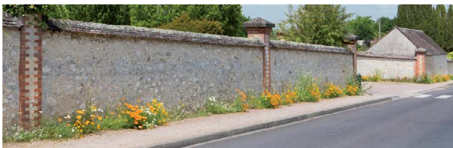
Les semis de pieds de murs, rue du la chapelle
